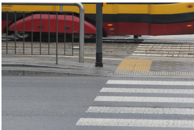
Rysunek 1 Obniżenie krawężnika przy przejściu dla pieszych.
