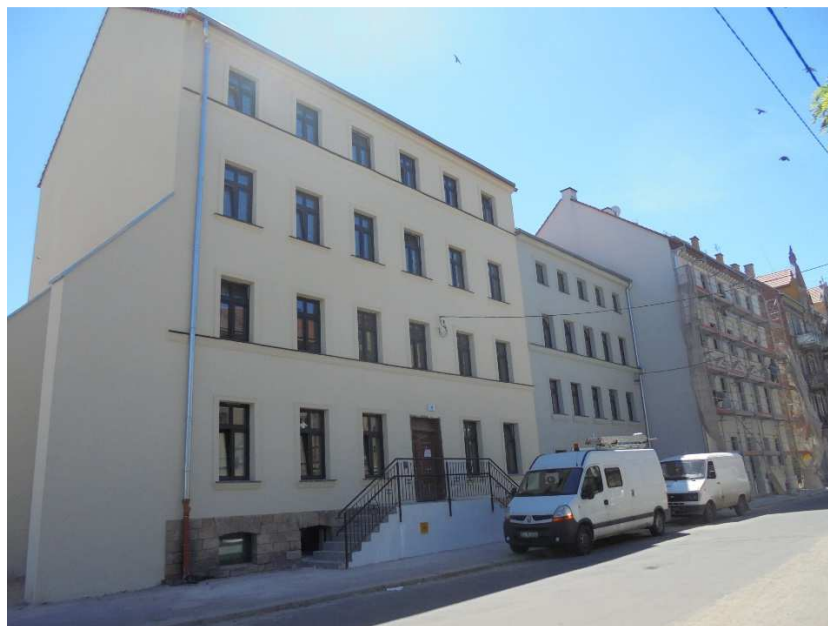
Budynek przy ul. Kamiennej 6 w trakcie renowacji.
