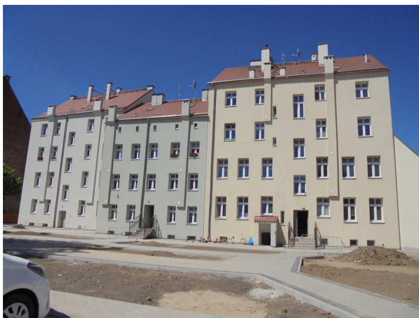
Budynki przy ul. Kamiennej 4, 5, 6 w trakcie renowacji (od strony podwórka)
