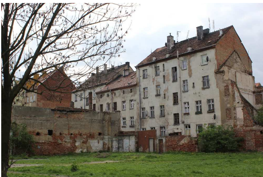
Budynki przy ul. Kamiennej 4, 5, 6 przed renowacją (od strony podwórka)
