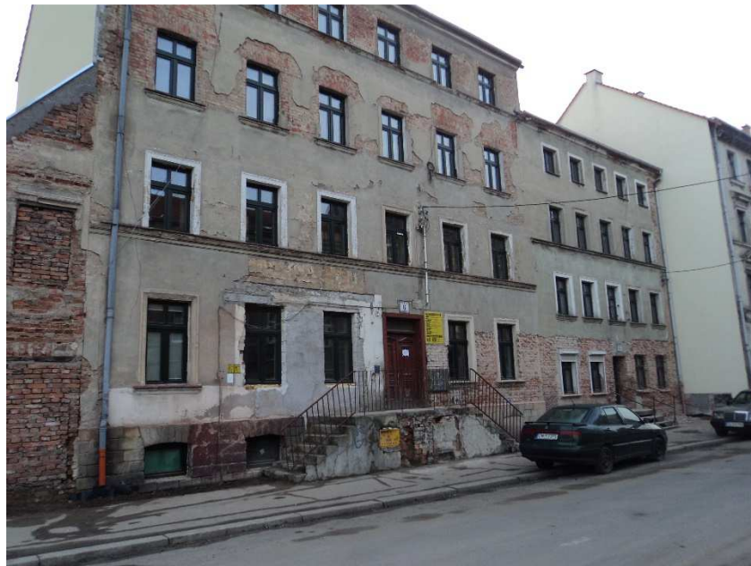
Budynek przy ul. Kamiennej 6 przed renowacją.
