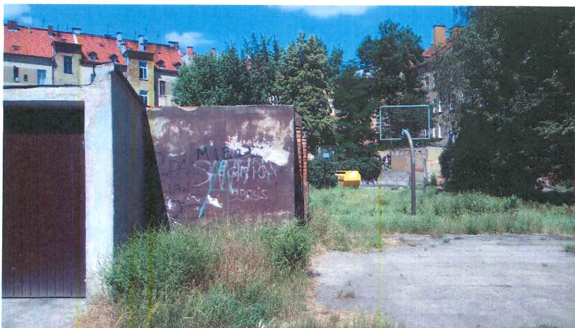
Fot. 1. Tył budynku gospodarczego przeznaczanego do rozbiórki w ramach zadania inwestycyjnego (LBO)
