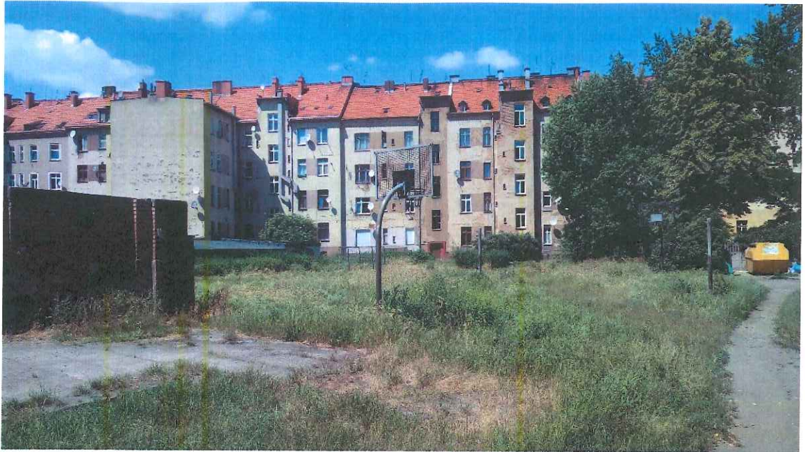
Fot. 2. Bok budynku gospodarczego przeznaczonego do rozbiórki w ramach zadania inwestycyjnego (LBO)
