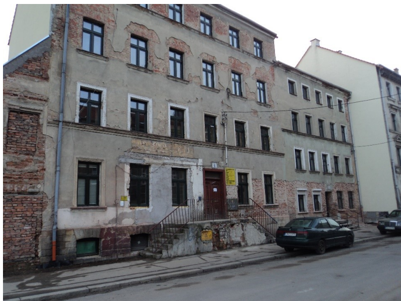
Budynek przy ul. Kamiennej 6 przed renowacją
