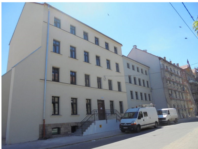
Budynek przy ul. Kamiennej 6 w trakcie renowacji.
